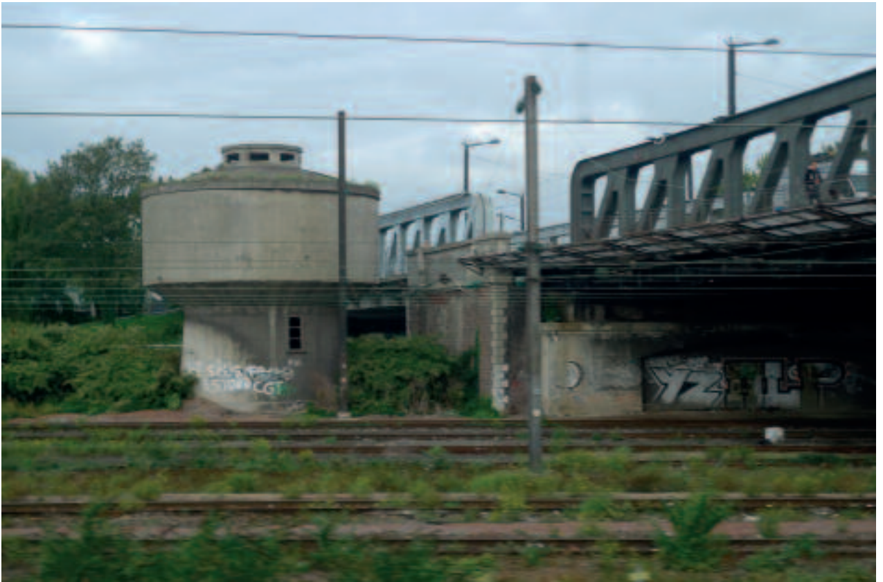
Réservoir décanteur et collecteur d'eau (avenue de Dunkerque, Valenciennes)
